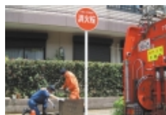
▲消火栓の点検のようす
