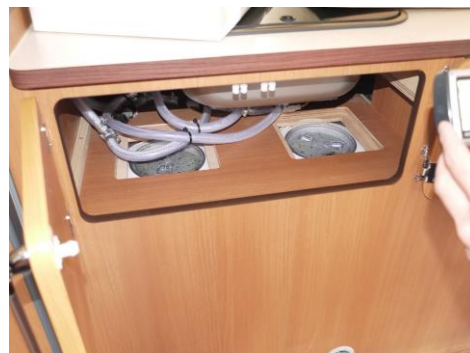
清水タンク点検口
