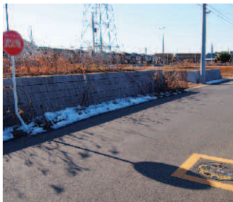
消火栓と標識
