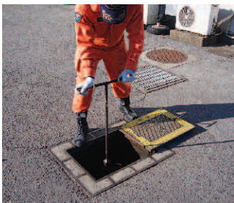
消火栓点検の様子
