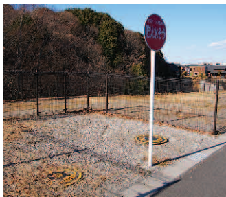
防火水そうと標識
