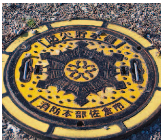
防火水そうの蓋には金属製の他に、コンクリート製もあります
