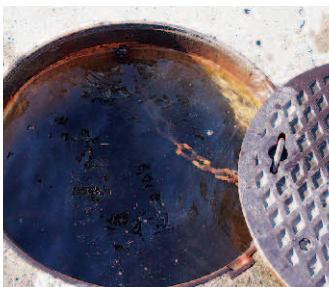
防火水そうの中の様子
